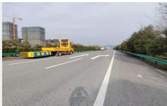
图：更换交安设施
